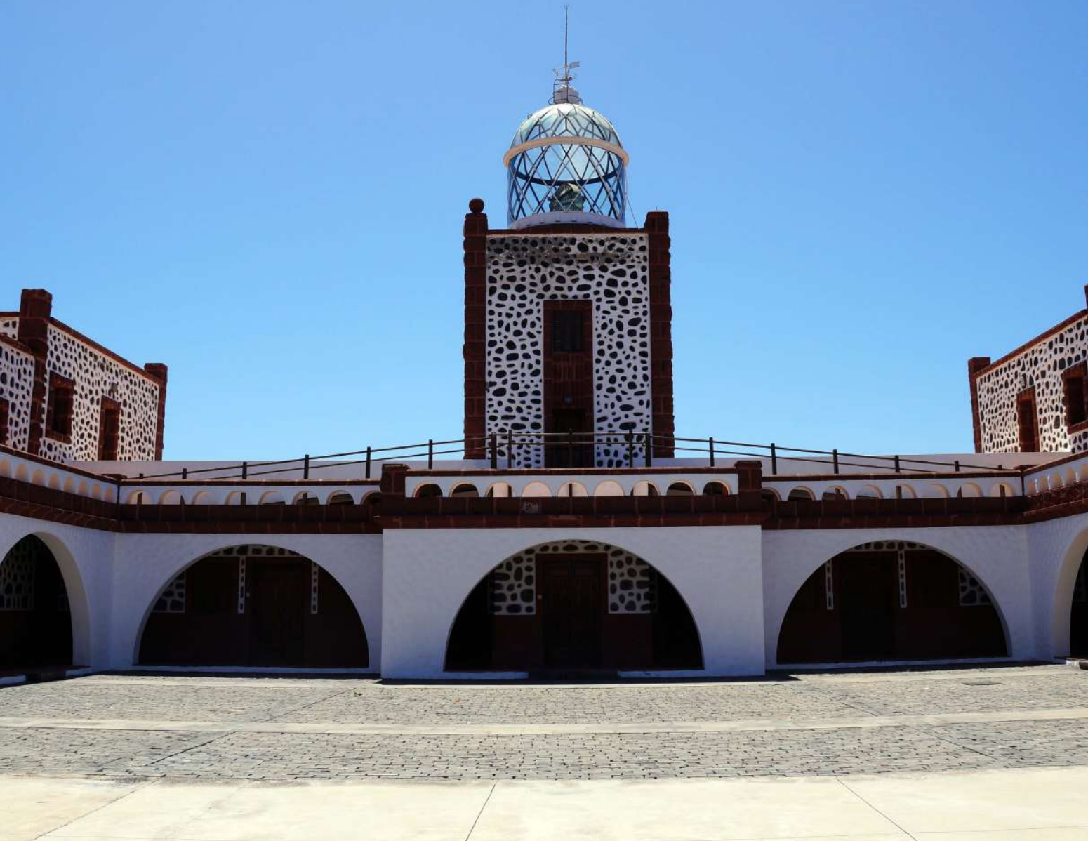
Vista posterior del faro de la Entallada, Fuerteventura Fotografía: JNF
