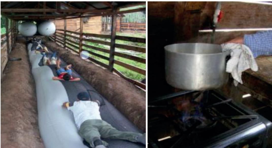
Figura 8. Sistema de producción de biogas y bioabonos instalado en Tocache.
