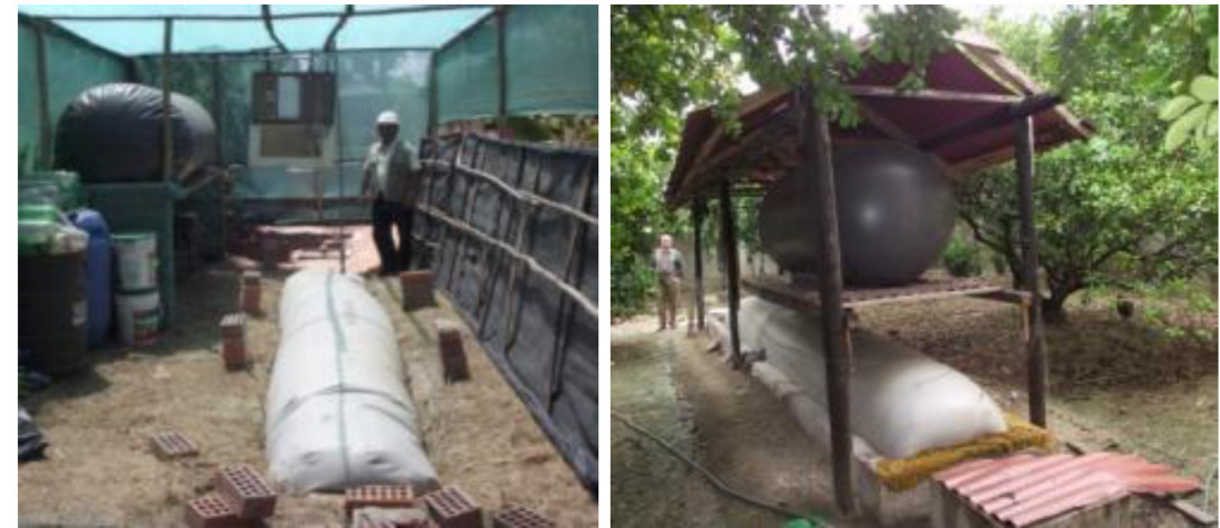
Figura 7. Sistema de producción de biogas y bioabonos instalado en Trujillo y Cumba
