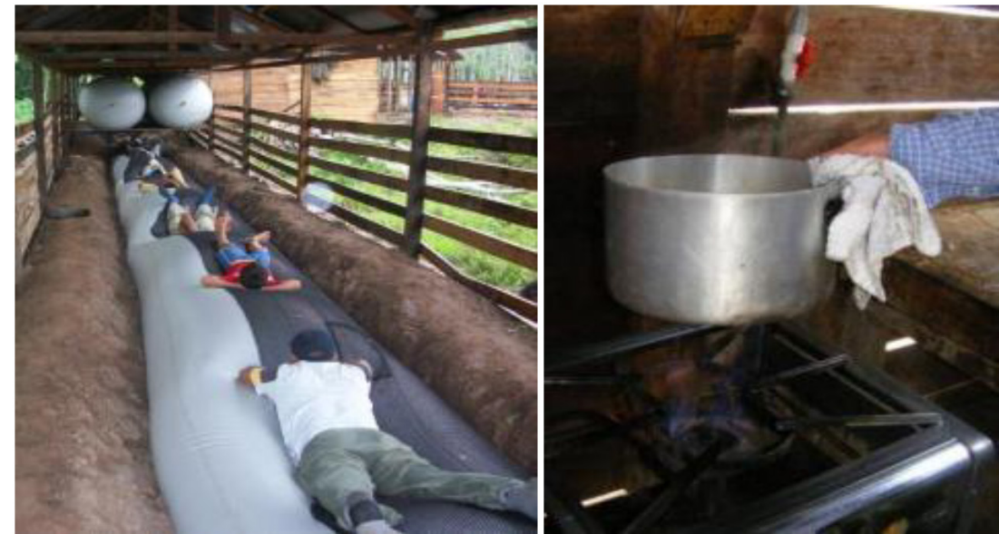
Figura 8. Sistema de producción de biogas y bioabonos instalado en Tocache.
