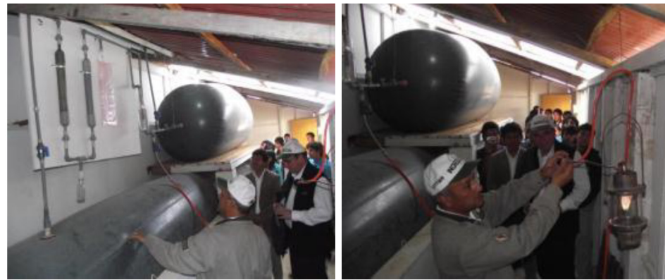
Figura 3. Sistema de producción de biogas y bioabonos instalado en Chachapoyas
