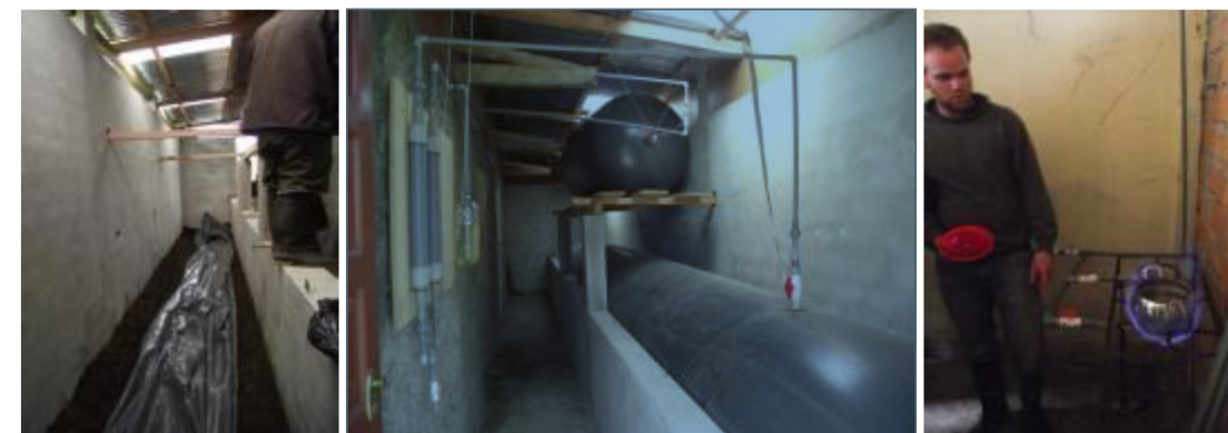
Figura 2. Sistema de producción de biogás y bioabonos instalado en Pomacochas.
