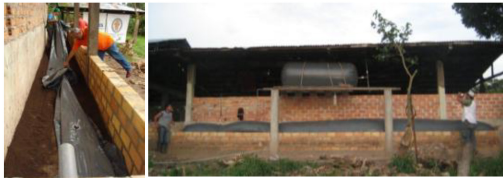
Figura 4. Sistema de producción de biogas y bioabonos instalado en Calzada
